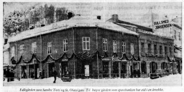
Falkgården mot Søndre Torv og St. Olavs gate. Til høyre gården som sparebanken har eid i en årrekke.
