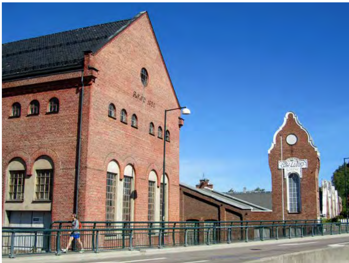
Hønefoss kraftstasjon I ferdigstilt i 1920 som et element i Hønefoss Brugs bygningsmasse.
