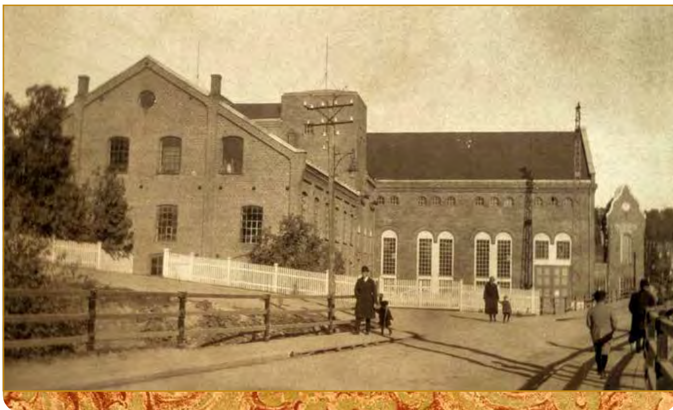
Hønefoss kraftstasjon og Hønefoss Brug. Gatebilde med Øyabakken (Arnemannsveien) opp til venstre.
