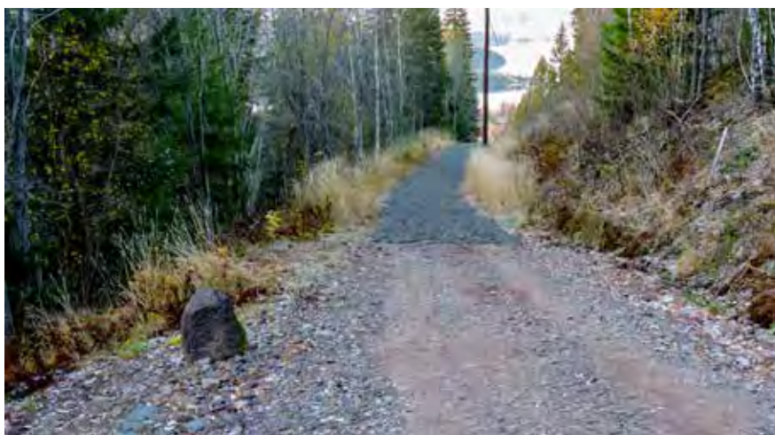
Nederst, fra Flaten og nedover, er det ikke gjort annet enn å utbedre stikkrenner og å finne ut hvor veien egentlig ligger. Det er lagt på knust masse midlertidig for å gjøre veien lettere å gå.
