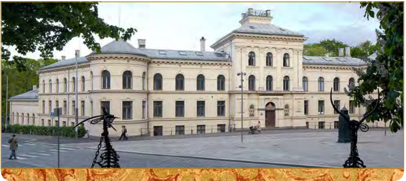
Bygningen som huset Norges geografiske oppmåling i hundre år fra 1880 til 1980, St. Olavs gate 32, Oslo.
