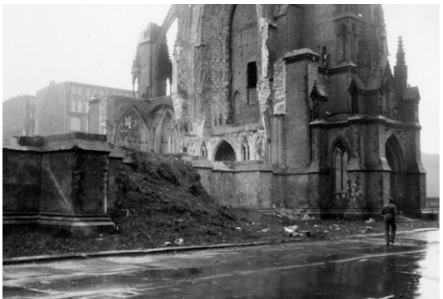
Bombet kirke i Hamburg, hvor deler av sentrum ble lagt i ruiner i 1944.
