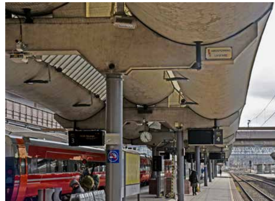
HP-skall som plattformoverbygg på Oslo sentralstasjon.
