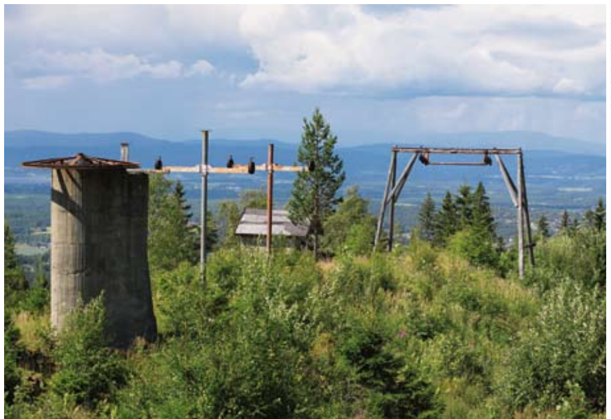
Restene av tønneheisen ved Kleivstua
