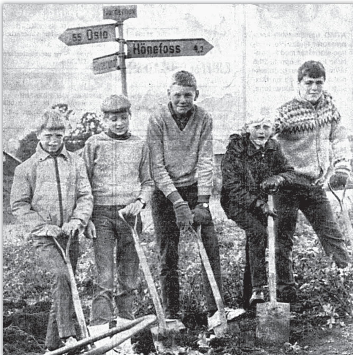
“Trafikkøya i Hønenkrysset skal forsvinne og krysset reguleres på annen måte. Kirkeskolens foreldrelag har fått rosene som sto der, og 7. klasse under ledelse av lærer Halden har tatt opp rosene for å jordslå dem på skoletomta, det tas sikte på salg til våren (1970). På bildet ser vi fra venstre Leif Skagnæs, Ole Rishovd, Håkon Hagen, Gunnar Gabrielsen og Lars Buttingsrud i ferd med å ta opp rosene.”
