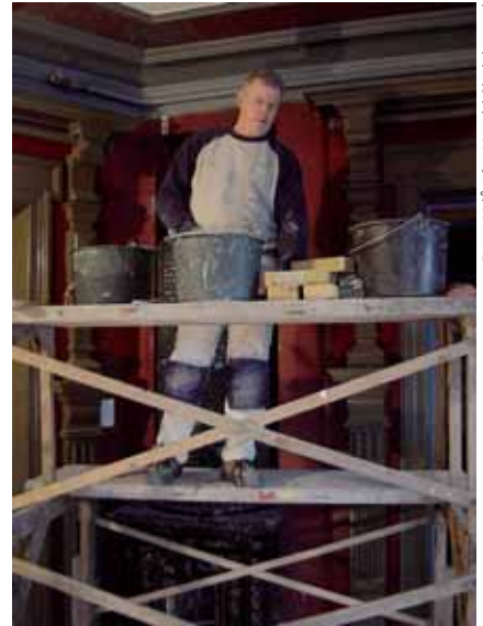
Restaureringen, med kakkelovn-ekspert Harald Sjødalstrand på stillaset, nærmer seg slutten.
