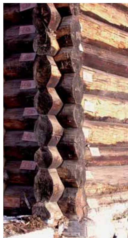
Laftearbeidet hadde høy kvalitet. Bildet viser et hjørne med laftehoder i karakteristisk bølgeoval form.
