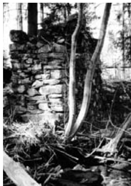
Steinmur etter Peder Ankers Oppgangssag, Kjerratsaga. (Foto: Arve Frydenlund)
