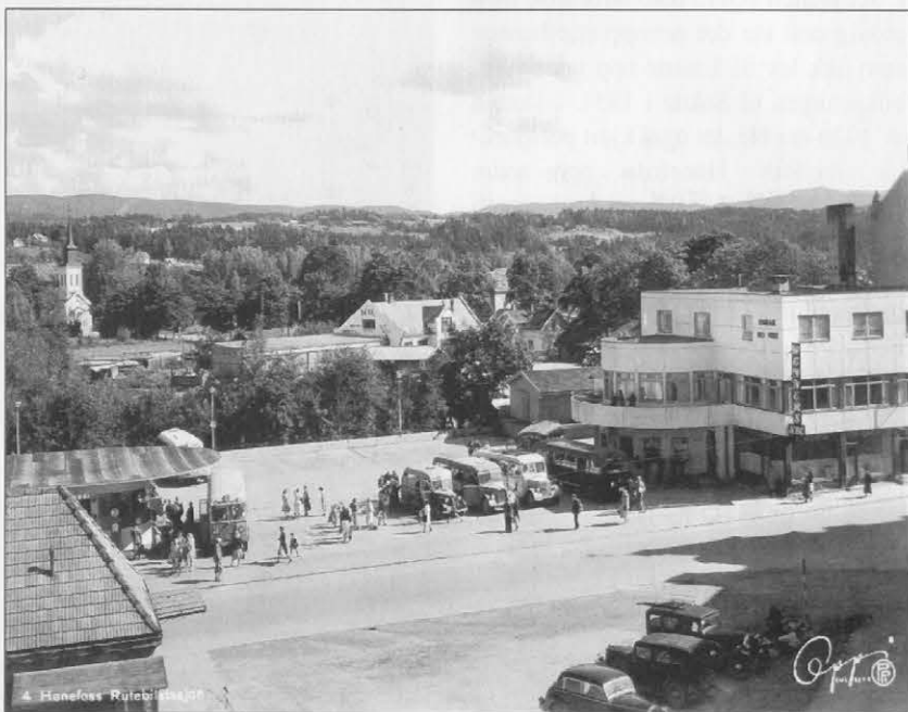
Rutebilstasjonen, første utbygging, med Venne kro, Kjøttkontrollen og den gamle hestevanninga. (Fotografi lånt av Håkon Løbben)
