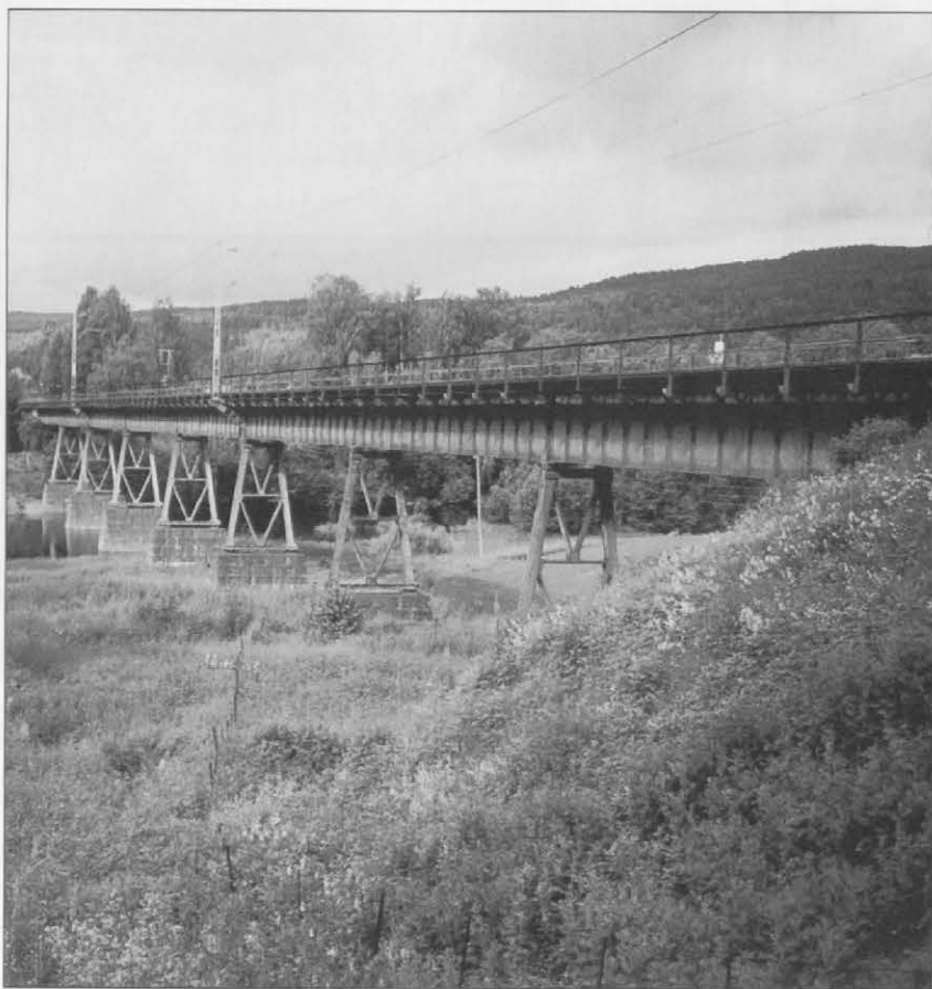
Bjørkebrua som ble åpnet 1936. (Foto: Kjell Lundstad)
