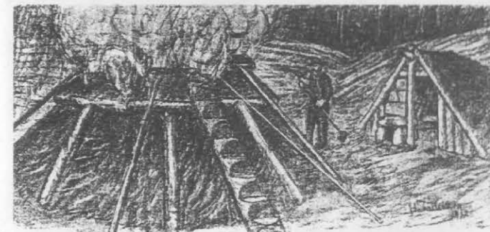
Kølmile og milekoie (etter tegning av Hans Holmen 1912, gjengitt i Hedrum bygdebok). Tufter etter milekoier finnes ved mange kølabanner.
