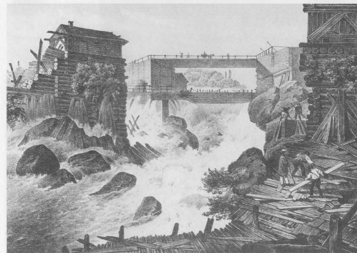
På vedföiede Prospekt seer man de for vore Fosse karakteristiske Kombinationer af Broer og Sauger og Lendser og Render samt Steenkister som Grundpiller for Bygningsværkerne.
