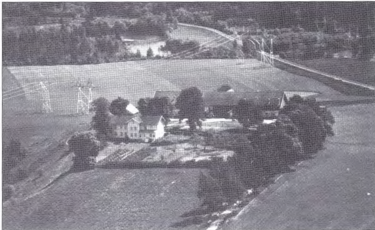
Hov gård, med Randselva og Bergensbanen i bakgrunnen. Bildet er tatt tidlig på 1950-tallet.
