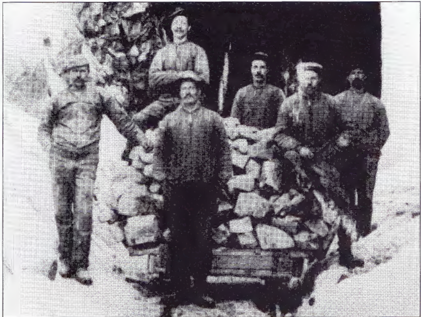
Anleggsarbeidere ved Bergensbanen i Soknedalen 1908/09. Dersom Ringeriksbanen kommer til utførelse, vil maskinene overta den jobben disse gutta gjorde for nesten 100 år siden. (Foto: Norsk Jernbanemuseum, Hamar)
