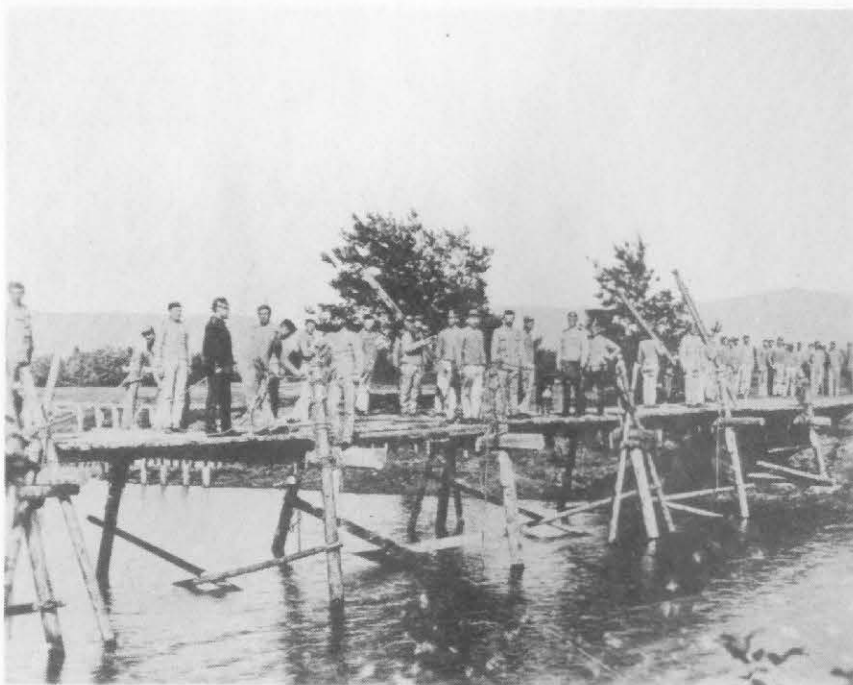
Feltbrobygging på Helgelandsmoen.
