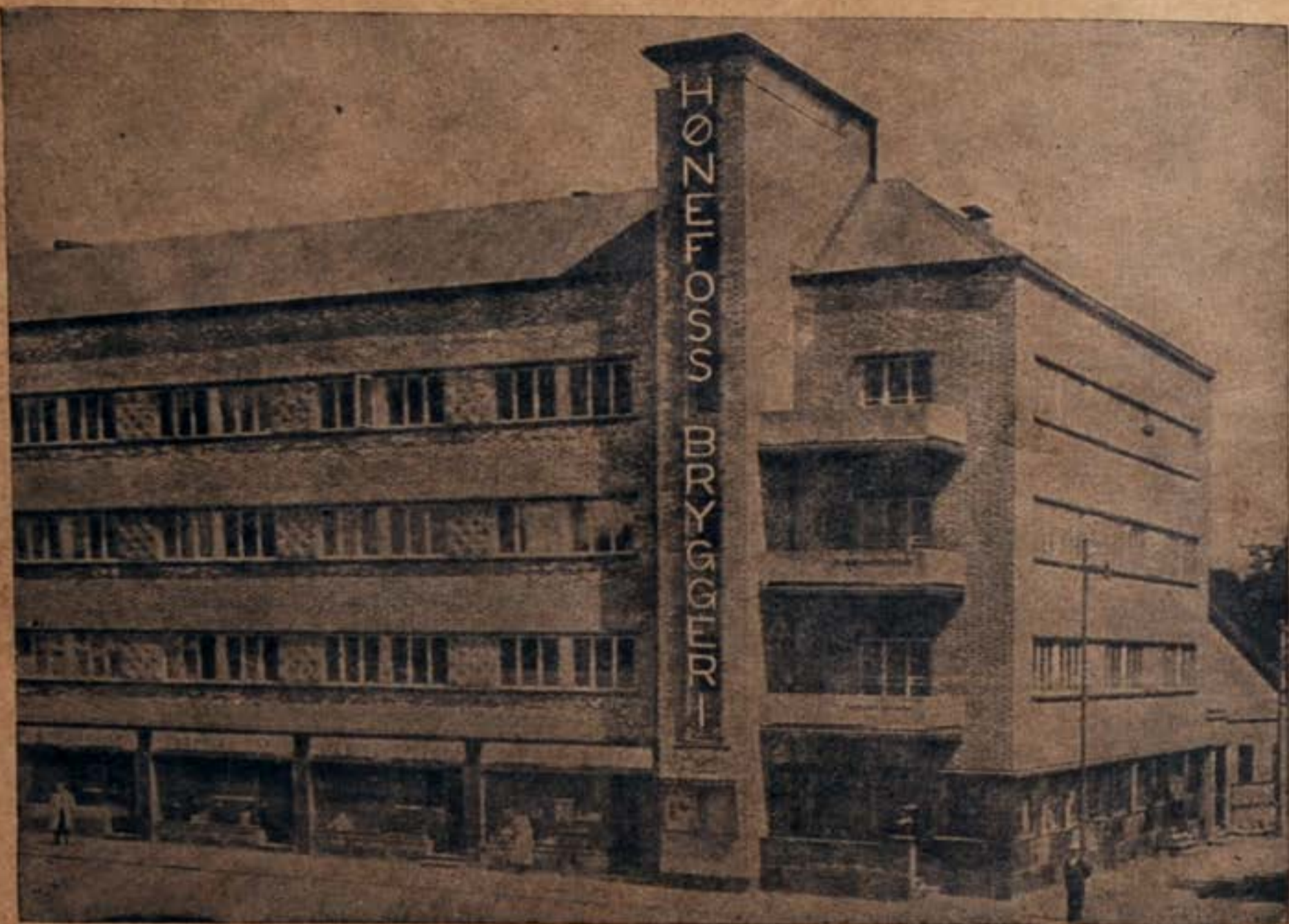
Ti meter under dette bygg lagres det gode Hønefoss brygg
