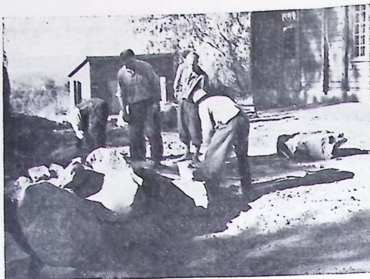
Steinene fjernes etter at de er tegnet og målt. Dannevig Hauge i knikkens.
