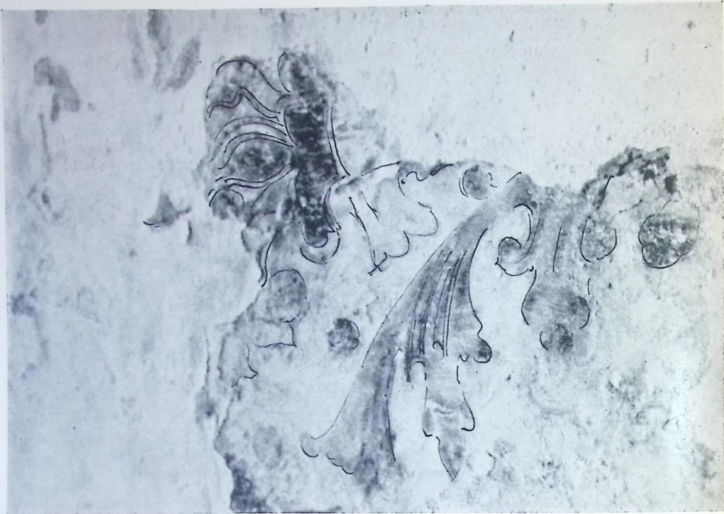
Rester av ornamentikk under pussen i Hole kirke.
