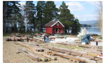
Grunnmuren klar på Sundvollstranda og tømmeret utover i mai 2006.
