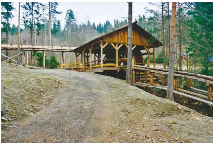
Hjulhuset er ferdig.
