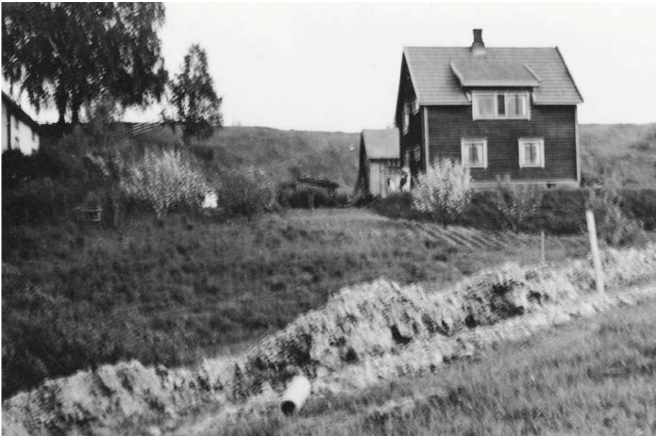
Fotoet viser deler av gravingen for legging av rør til vann og kloakk. Legg merke til at langs bakketoppen i bakgrunnen finnes ikke et eneste hus.
