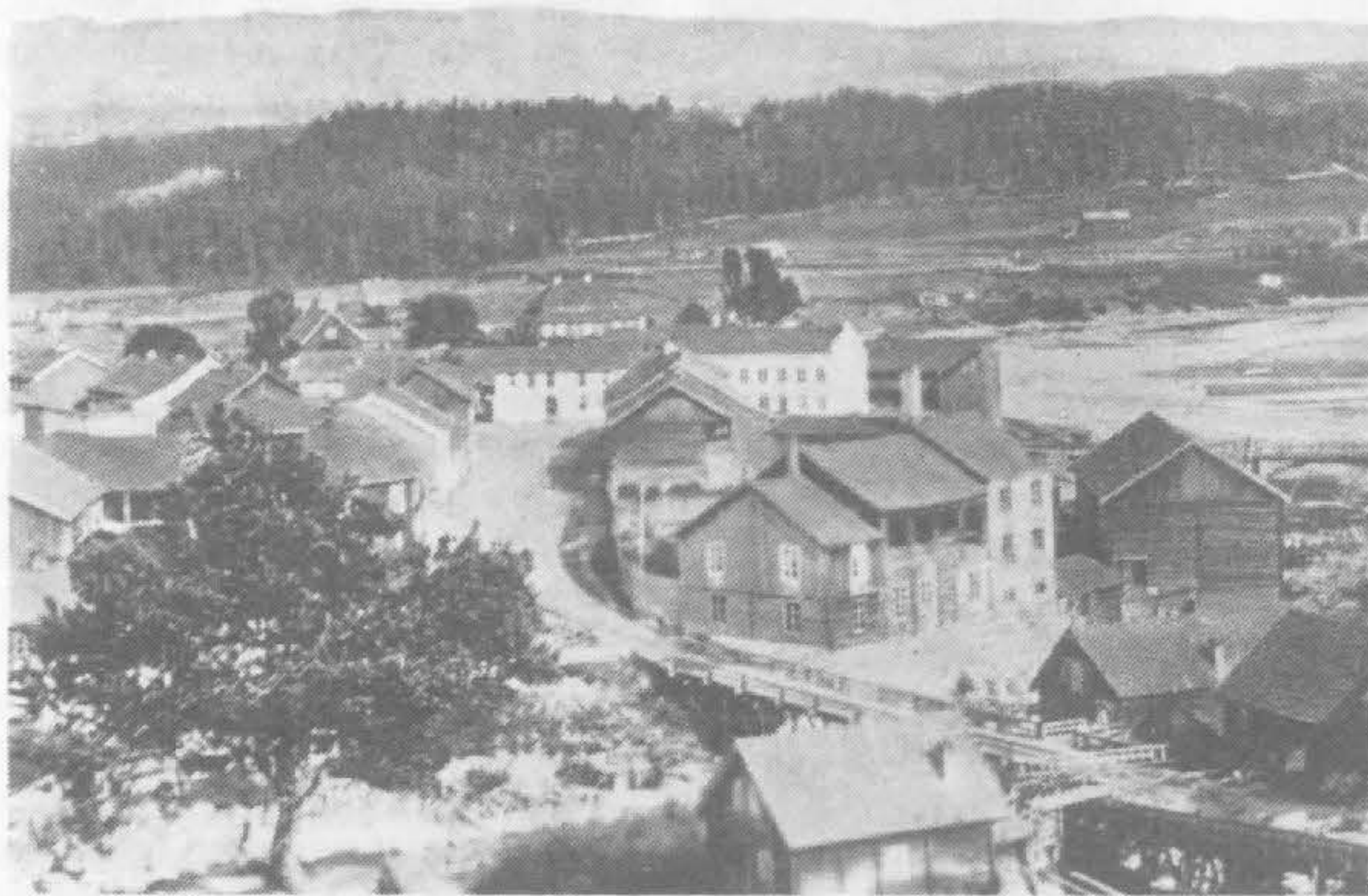
Fra Nordsiden før brannen 1878.
