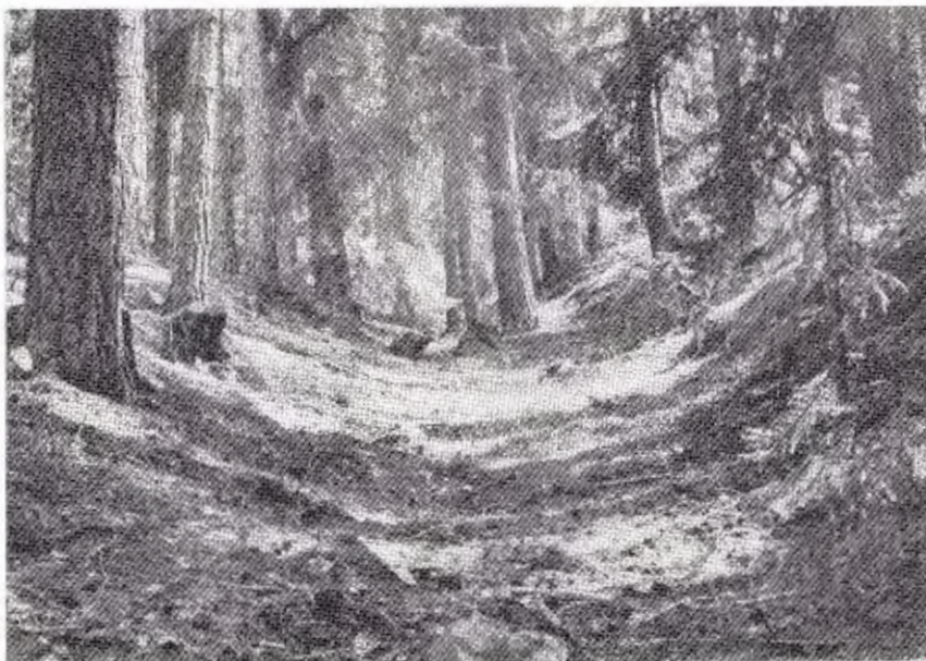
Fra Kjerrat nr. 4. Gjennom Pjaakahavna måtte kjerrattrasséen senkes i terrenget for å få en tilfredsstillende rullebaneprofil. (Norsk Skogbruksmuseums billedarkiv).
