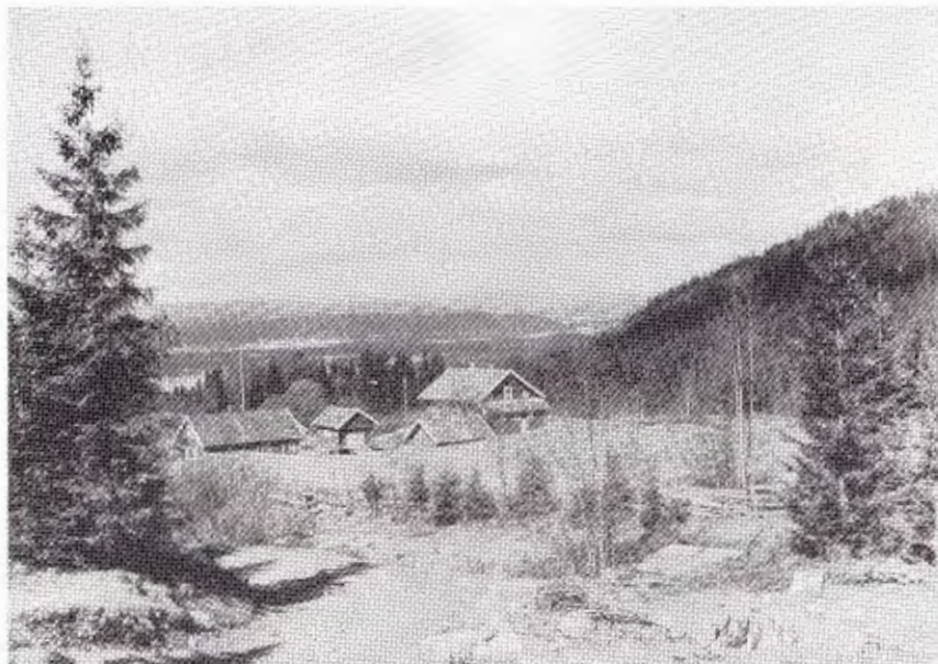
Stubdal i Åsa, ca 1945. "Vaktslottet på Stubdal, som Peder Anker lot bygge ca. år 1800, var i bruk i hele kjerrattiden, bl.a. som jakthytte. "Slottet" var beskjedent i størrelse, restene av grunnmuren viser ca. 8 x 7 m, det var bygget i to etasjer og sto inne på volden til høyre på bildet. I dag er tomten bevokst.
