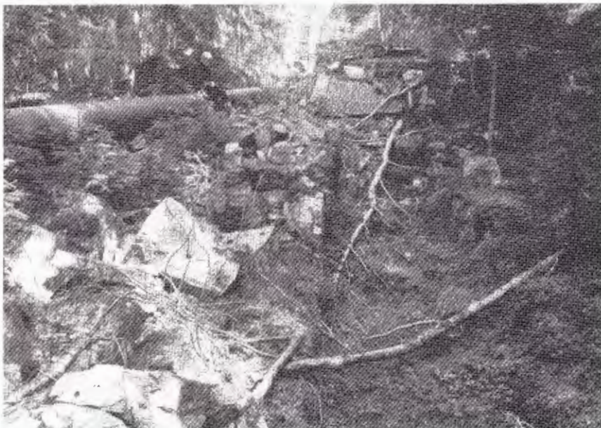
Kjerrat nr. 7. Restene av hjulhusfundamentet. Konturene av hjulkjelleren sees til høyre på bildet. (Norsk Skogbruksmuseums billedarkiv).
