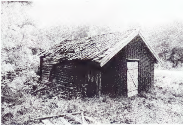
Badstua før nedtagning på Elstangen 1979.
