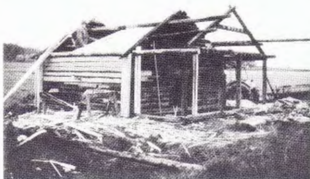
Under oppføringen på Mo. Nye stokker er lagt inn i langveggen og i flere andre stokker er det spunset inn nye deler. Undertaket legges.
