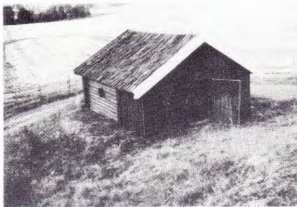
Badstua ferdig restaurert og malt sommeren 1982. Legg merke til strammeanordningen på langveggen som røper at dette er en badstu.
