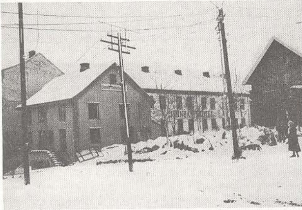
Jernbanehotellet, nå Grand Hotel, ca. 1910. Fløyen langs Stabells gate ble revet i 1912 da den nåværende fløyen mot gata ble reist. Den andre fløyen ble bygd i 1885 av Ole Helgesen. For enden av den lå stall. Til høyre ser vi bygningen som rommer grisehus, ishus og vognskjul.
